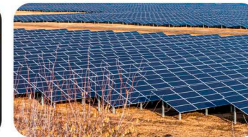
Nueva planta solar fotovoltaica
