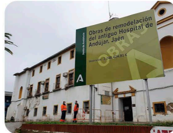
Rehabilitación del Hospital Viejo
