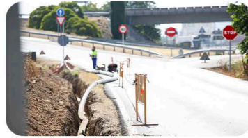
Renovación suministro agua de L Sotillo
