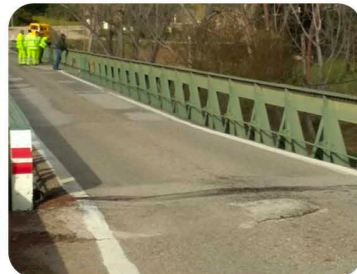
Arreglo del Puente de Hierro
