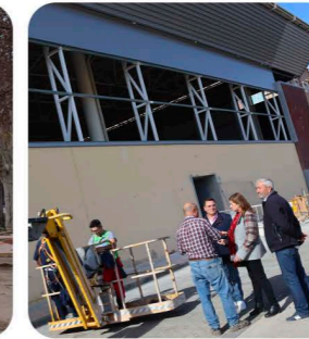
Insonorización del Pabellón Ferial
