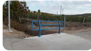
Canalización de aguas en las Vegas
