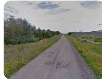
Arreglo de la carretera de Valtodano
